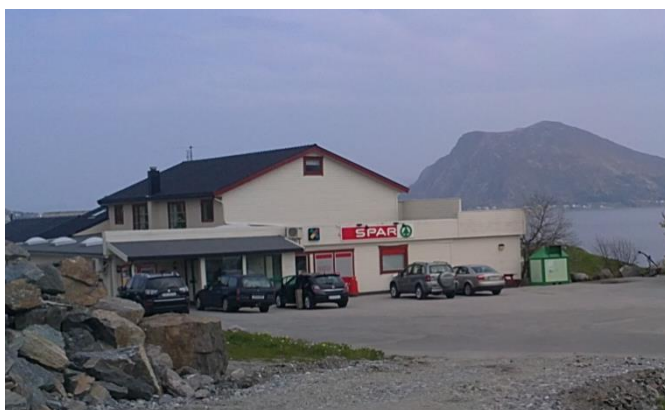
Butikkbygget mot sør
