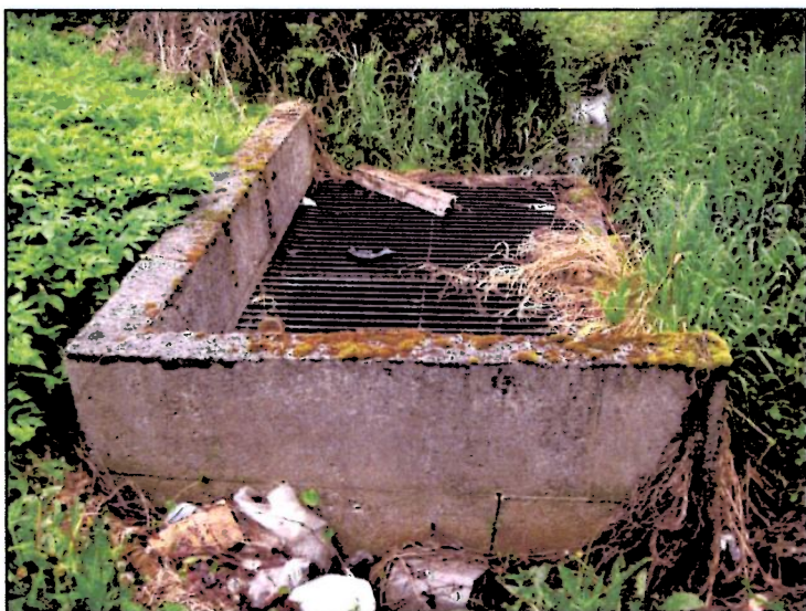
Figur 9 Det er store lekkasjar rundt overløpskummen, og nedre del av vatnet er seinka minst 50 cm pga. dette.
