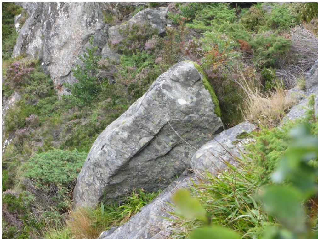
Figur 16: Blokk , merket 1 figur 15. Ligger integrert på berget: Regnes som stabil i dag, men over tid innen sikkerhetsklasse S3 som potensielt utspring.
