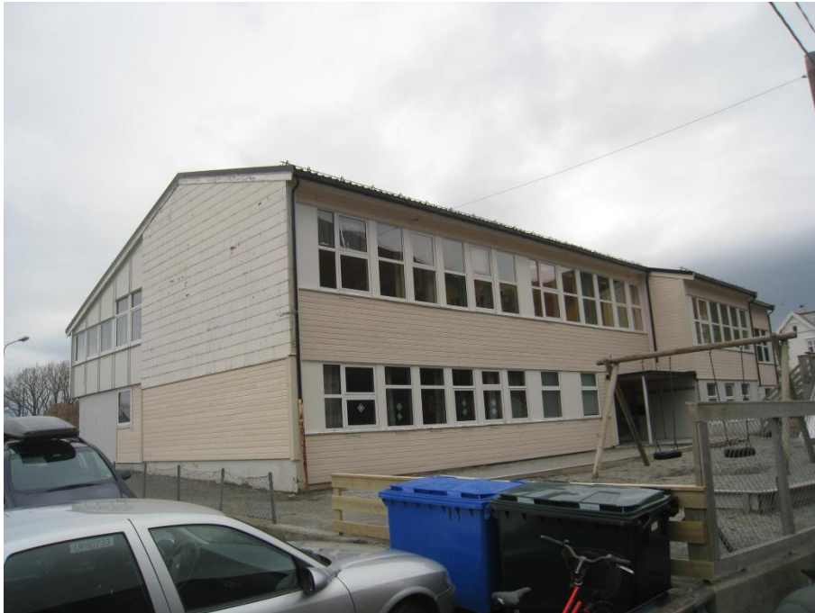
Figur 15: Bilde viser plassering av utvendige avfallscontainere
