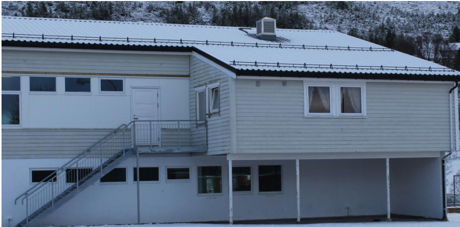
Figur 4: Bilde viser overbygg med arbeidsrom for lærere, samt utvendig rømningstrapp fra 1. etasje.
