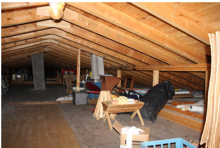
Figur 7: Bilde viser utførelse av loft, takkonstruksjon, bruk av loft, samt gulv i loft.
