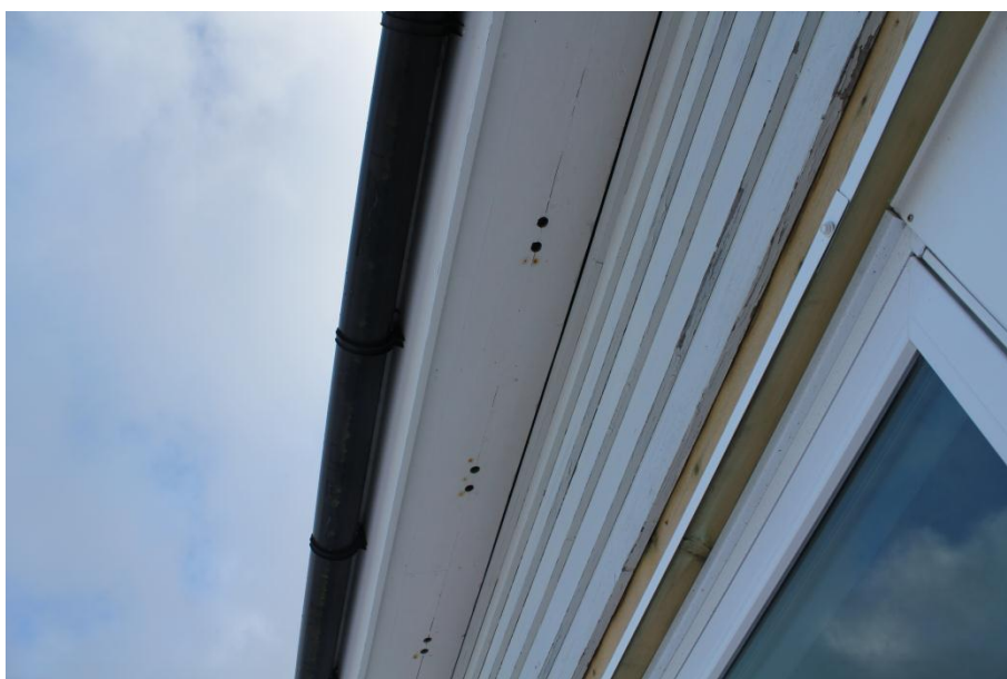
Figur 8: Bilde viser utførelse av lufting i gesimskasse.
