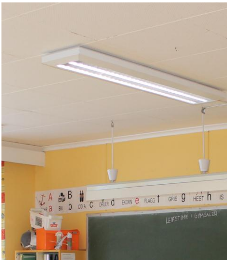
Figur 5: Bilde viser tak med lydplater i klasserom i kjeller
