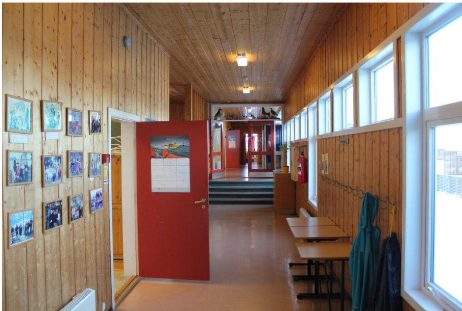
Figur 9: Bilde viser bruk av trepanel på vegger og tak i korridor. Vinyl på gulv.
