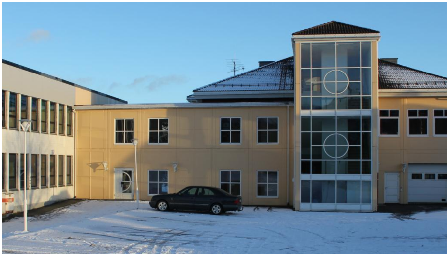
Figur 4: Bilde viser fasader mot øst i forbindelsesgang, samt tilstøtende fasader i gamle-bygget og nybygget
