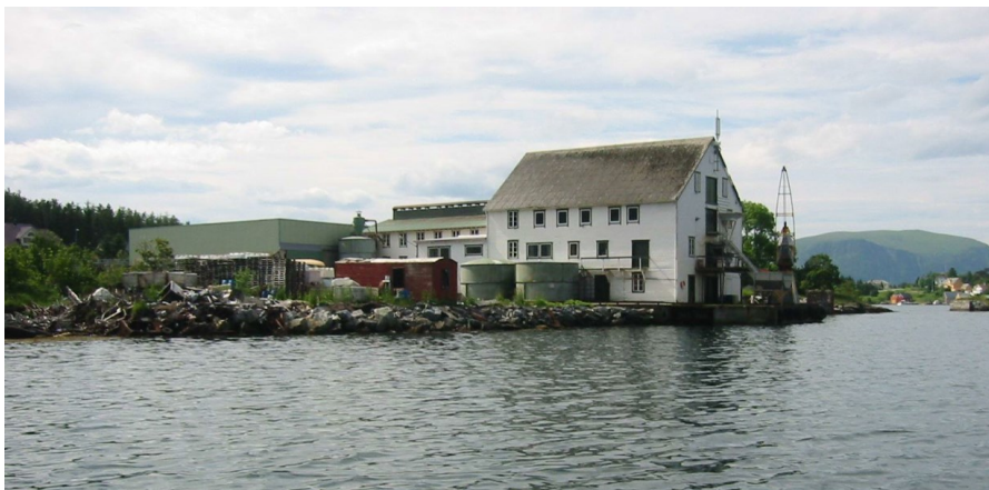
Eksisterende bygningsmasse på industriområdet
