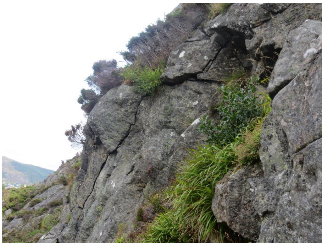
Figur 17: Løst parti, merket 2 figur 15. Flere potensielle utspringspunkter.
