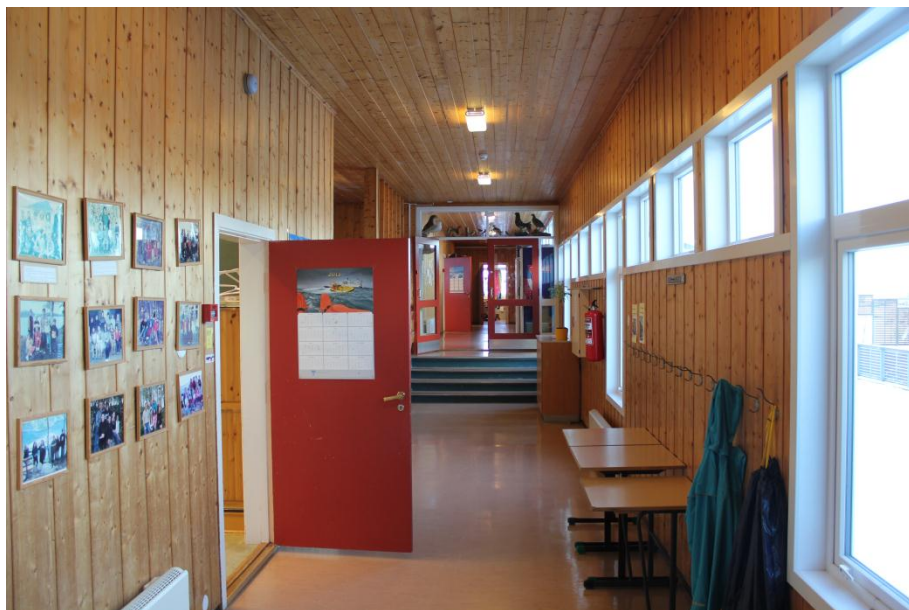
Figur 9: Bilde viser bruk av trepanel på vegger og tak i korridor. Vinyl på gulv.
