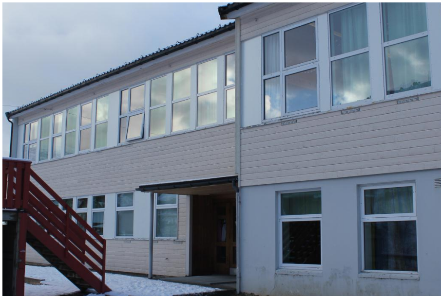
Figur 2: Bilde fasade mot vei, samt inngang i plan kjeller.
