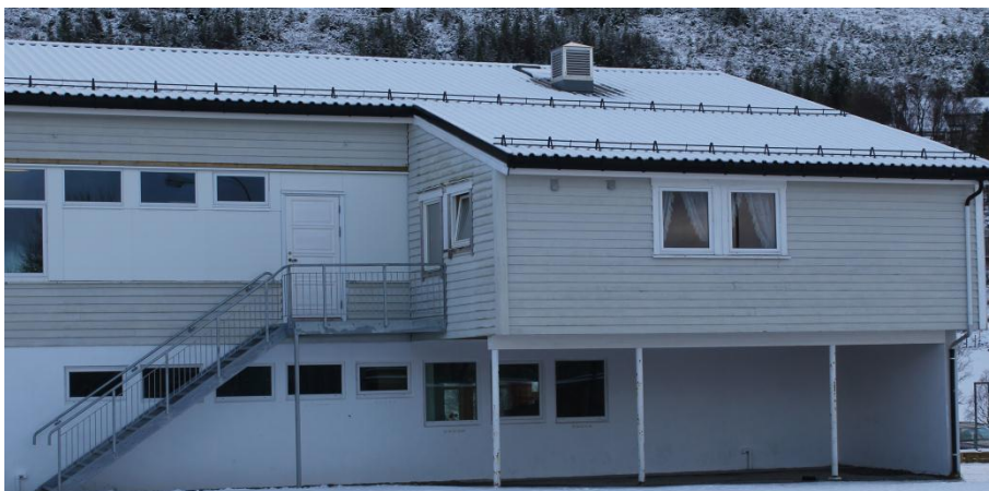
Figur 4: Bilde viser overbygg med arbeidsrom for lærere, samt utvendig rømningstrapp fra 1. etasje.
