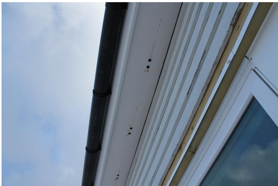
Figur 8: Bilde viser utførelse av lufting i gesimskasse.
