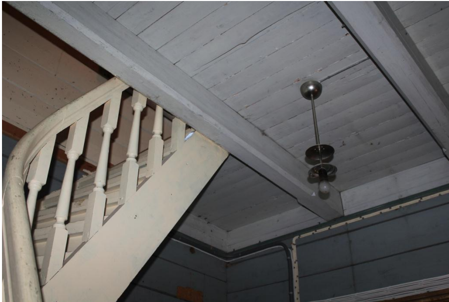
Figur 11: Bilde viser trappeløp mellom plan 1. etasje og kjeller.
