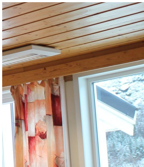
Figur 6: Bilde viser tak med trepanel i klasserom i 1. etasje
