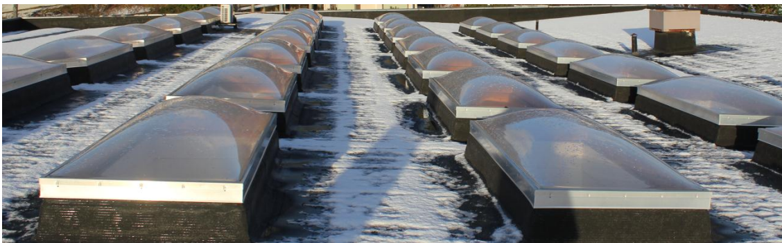
Figur 3: Bilde viser kupler for overlys på tak.
