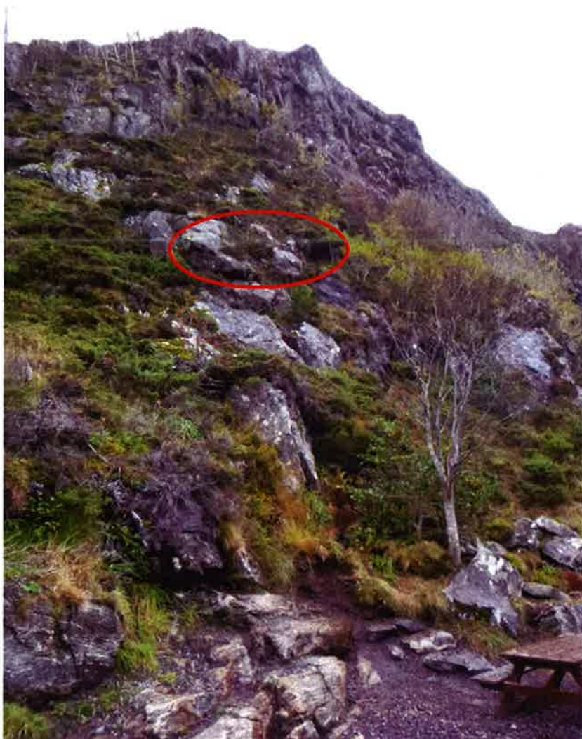
Figur 12: Figuren viser bergskråningen like ovenfor uteområdet til barnehagen. Innenfor den røde sirkelen ble det observert blokker som vurderes som delvis avløst.
