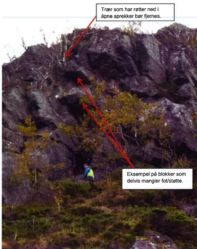
Figur 9: Bilde som viser Parti 5 og 6, med flere blokker som delvis mangler fot.
