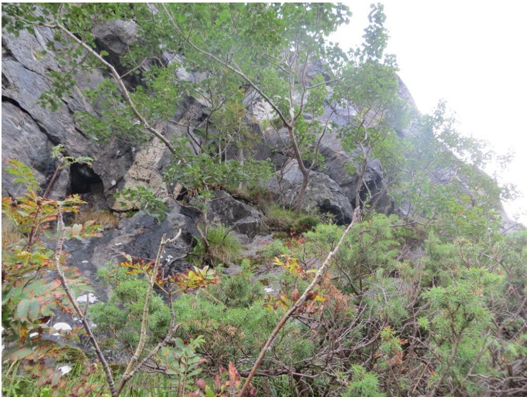
Figur 22: Ved foten av utspringsområdet i område 6 figur 15. Bildet viser utspring som har lagt seg ved foten av fjellet. Hyllen inn mot fjellet har et par meters bredde. Lite skal til før denne type utspring løper vider ned. Bilde figur 23 viser hvor vi er i forhold til barnehageområdet.
