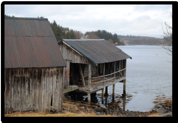
Svalgangshus, Aure. Foto :Fylkeskonservatoren
