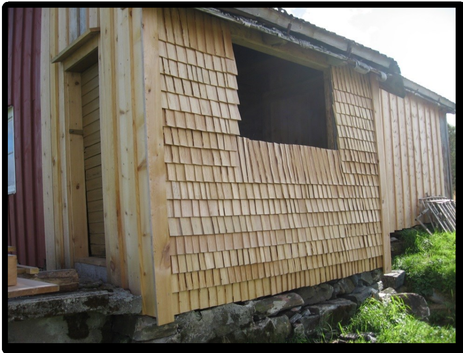
Frå Massinastua, Skotheimsvik i Fræna kommune, restaurert sponvegg. Fræna. Foto: Henry Ståle Farstad.
