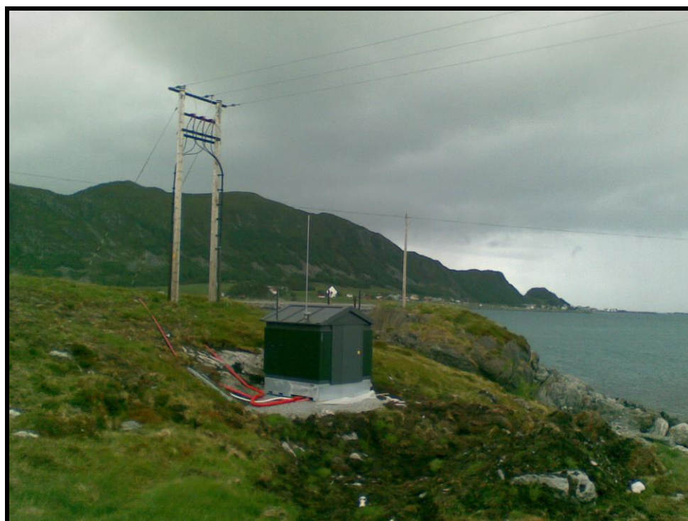
Figur 13. Foto (2012) av ilandføringsområdet og el-kiosken for sjøkabelen ved Sæviksteinen.
