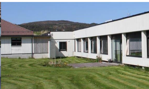
Bilde 8 viser seksjoneringsvegg mellom omsorgssenteret og helsesenteret i fasade mot sør.
