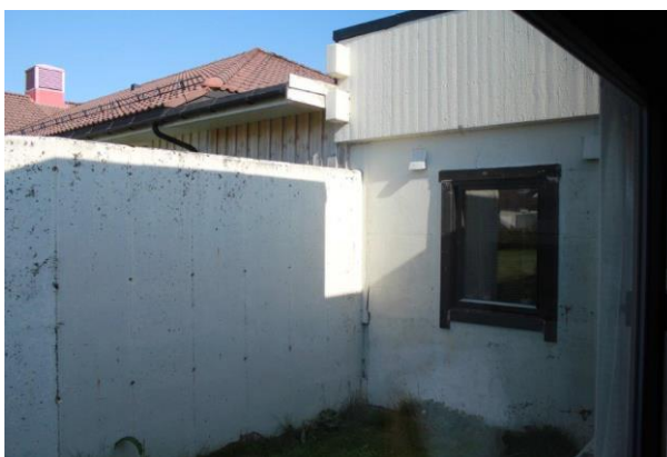
Bilde 10 viser utvendig skjermvegg som er etablert i forbindelse med oppføring av helsehuset.
