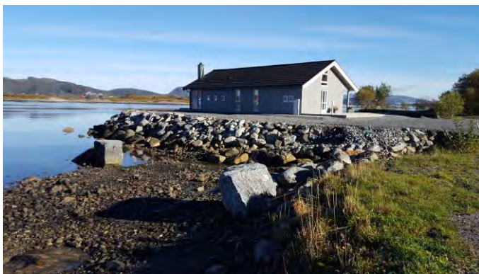
Eksisterande hytte utfyllt på steinmasser som er lokalisert på berg – grunnfjell i dagen.
