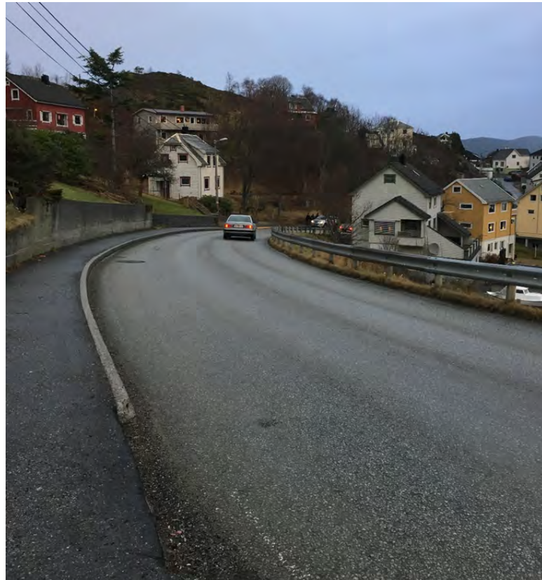
Figur 3: Eksisterende situasjon i Skarabakken (sett i retningen mot Fosnavåg).
