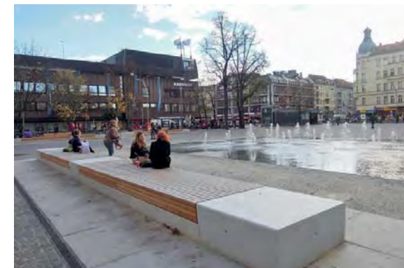
Betong benk med treinnslag
