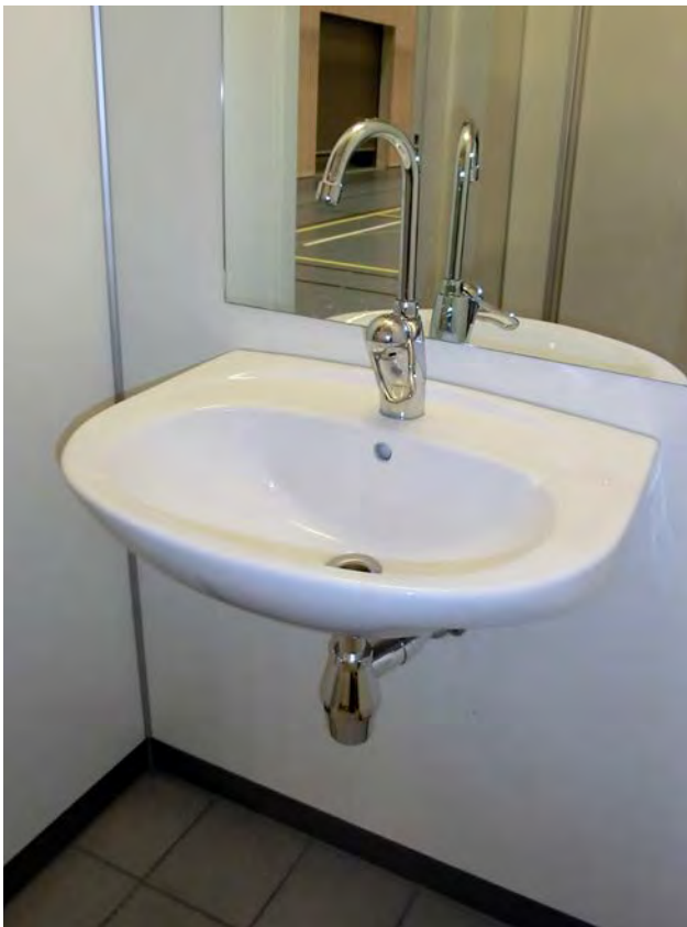
Servant med høy armatur – fungerer bra for fylling av drikkeflasker. Foto: Morten Roa
