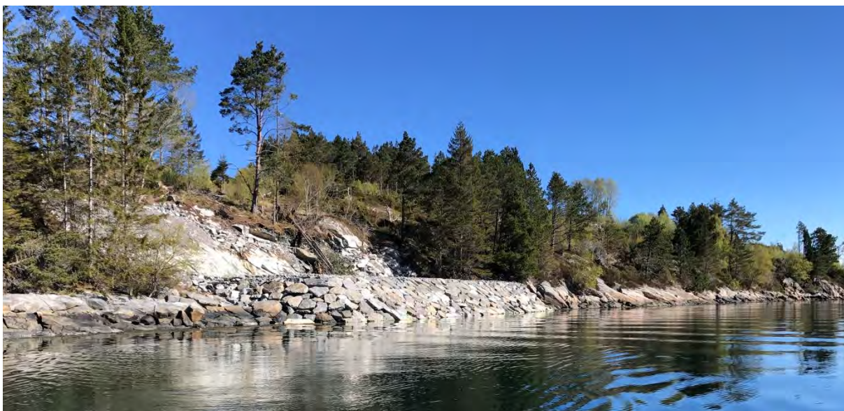
Figur 2: Bilde tatt mot nord fra sjøen av ferdig plastra fylling
