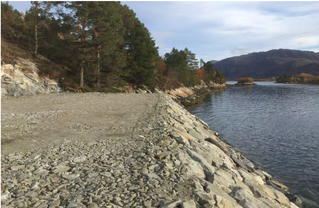
Figur 1: Bilde tatt mot nord av ferdig planert tomteareal
