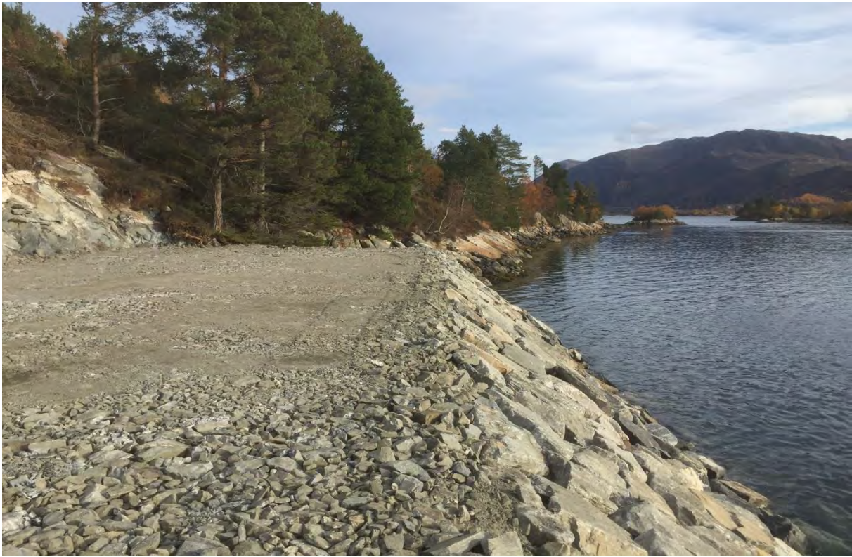
Figur 3: Bilde tatt mot nord av ferdig planert tomteareal
