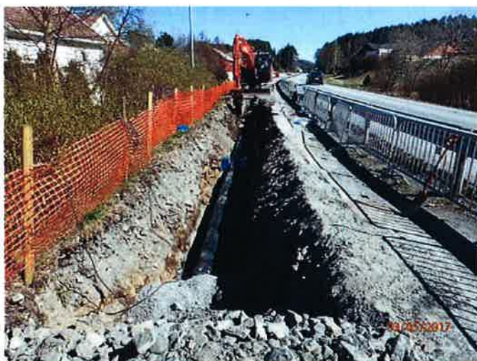
Borgarhaugvegen, Ny leidning i gangvegen
