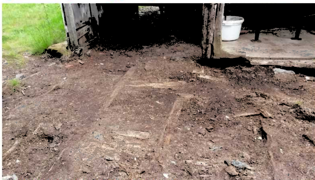
Figur 21: Overflatejord etter fjerning av avfall (juni-15).
