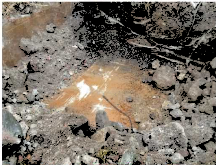
Figur 16: Sjakt under fyrkjel M33/100-4 (mars-15)
