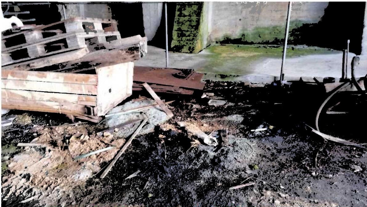
Figur 6: Løsmasser/kjemikalierester på gulv i lagerhall. M-33/30-S4 (juni-15)
