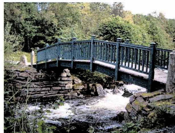
Figur 11 - I Elvadalen kan ein krysse Øyraelva på bruer som vist på bildet.
