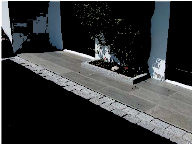
To rader storgatestein som skilje mellom ulike typar dekke.
