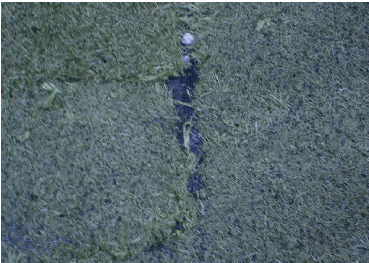
Flere steder var limskjøter løsnet og backingen kommet til syne
