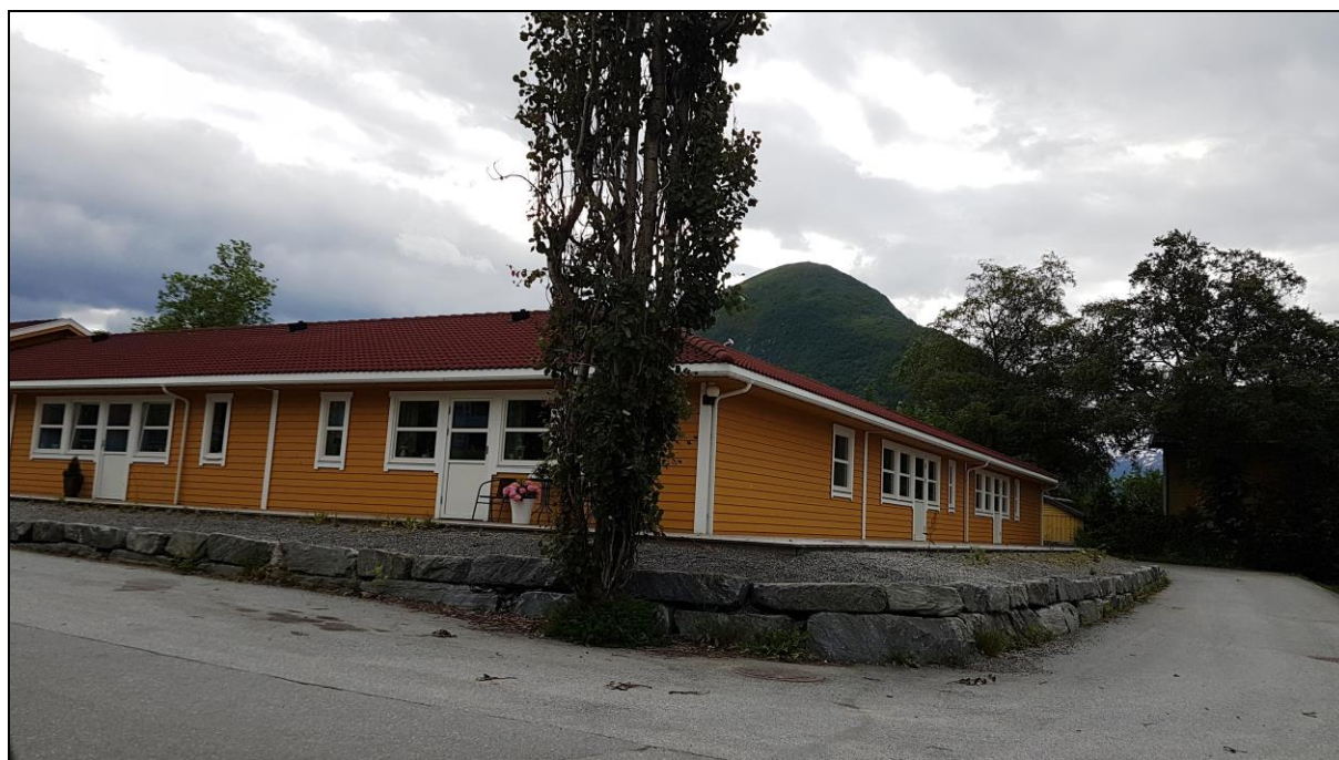
Delar av Sevrinhaugen bufellesskap sett frå vegen Sevrinhaugen
