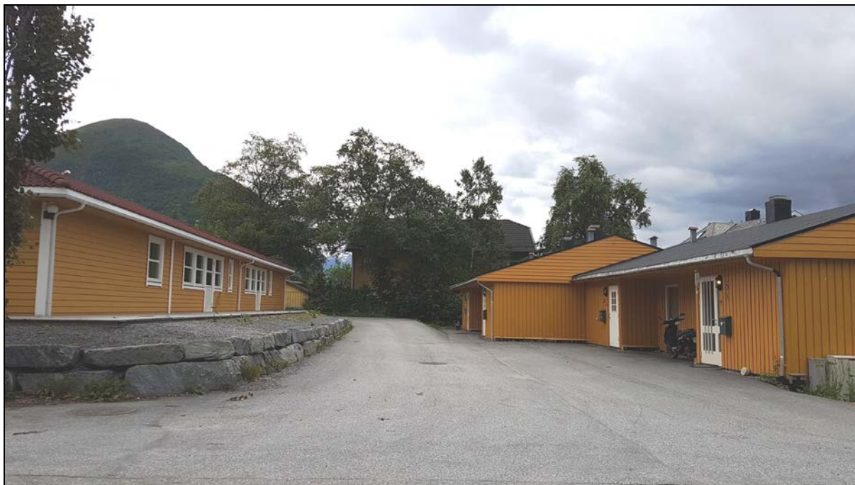
Tilkomstvegen mellom Sevrinhaugen 3 og 5
