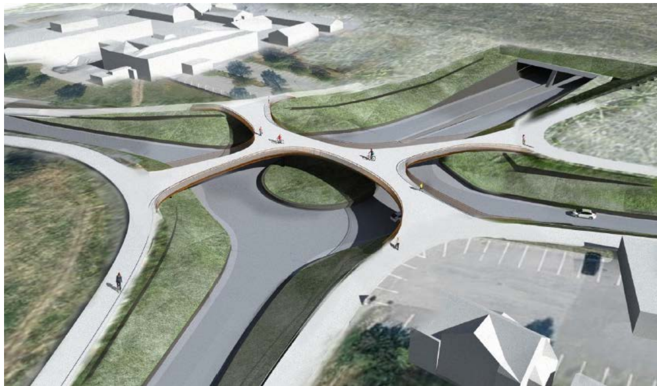
Figur 55 – Variant av 'stjernebrua' – eit mindre arealkrevande alternativ som kan vurderast for nærare prosjektering. Illustrasjon: Rambøll AS
