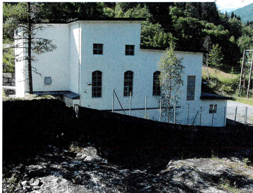
Kolfossen kraftverk, foto: Wikipedia
