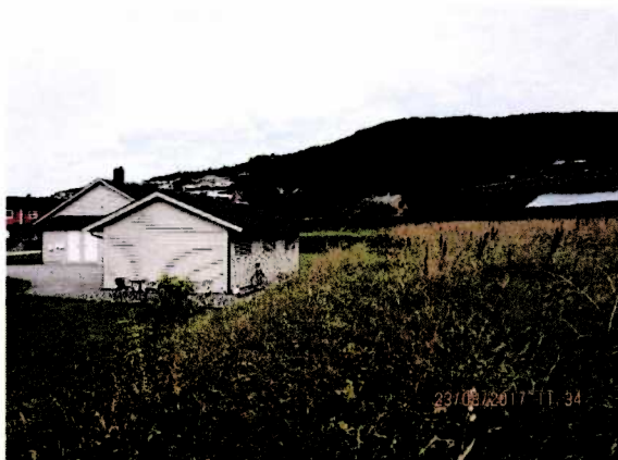
Figur 13: Garasje nord på gbnr. 19/985 (Røystunet borettslag)
