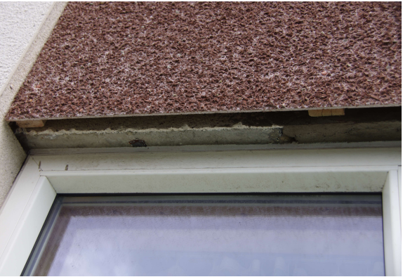
Bilde 2- Ekstra platekledt vervegg mot sørvest. Prinsipp lagt til grunn for fasade ALT.A
