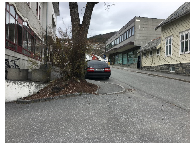
Figur 3: Storgata 6 og 8 til høyre, Storgata 5 til venstre.
