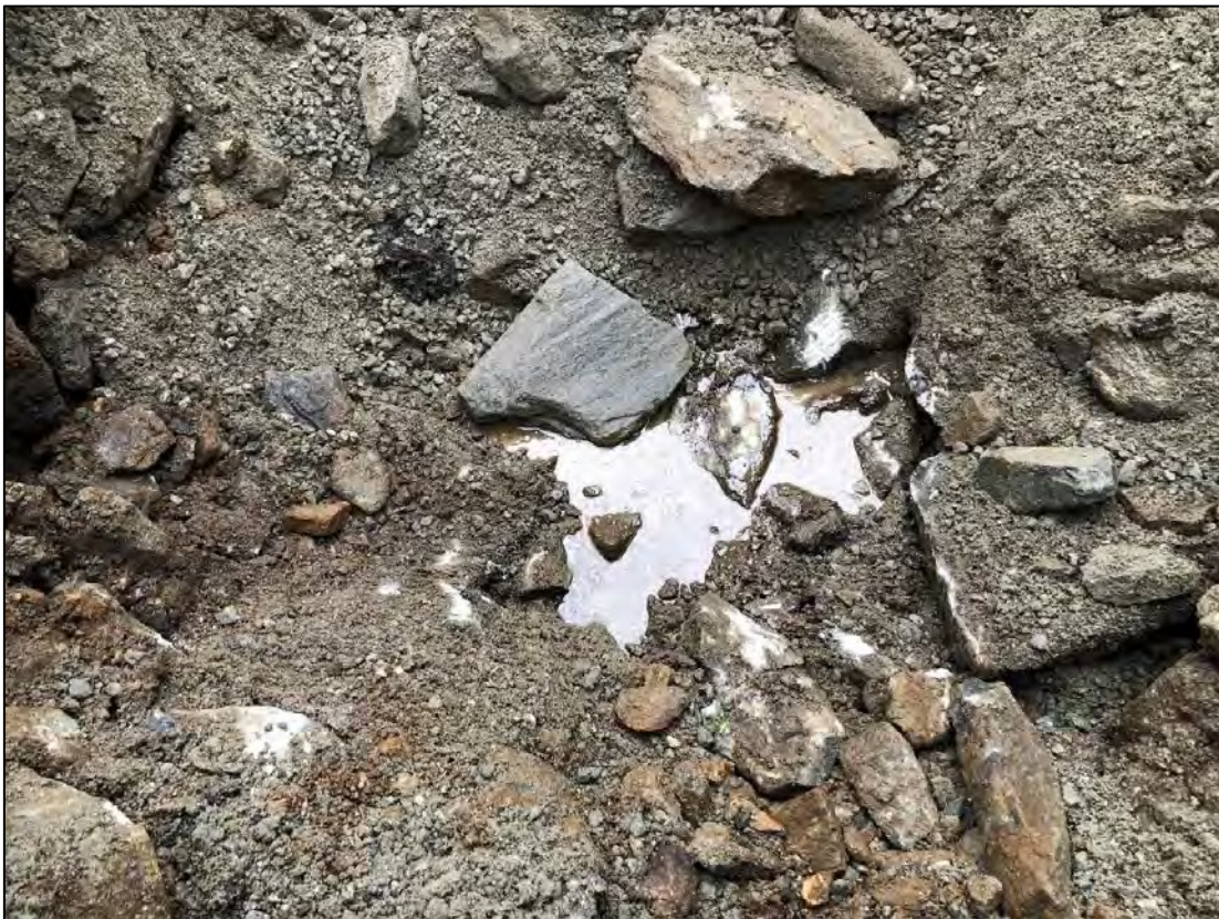
Figur 11 Punkt PG4. Massene består av sprengstein, sand og grus. Oljefilm observert på grunnvann.
