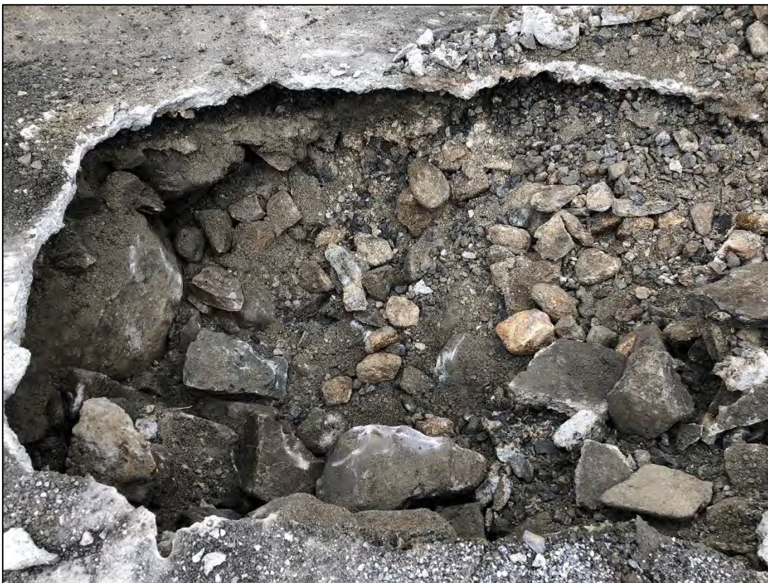
Figur 12 Punkt PG12. Avrettingslag av singel under betongplate. Sjakten ble gravd gjennom sprengstein med noe sand/grus, til pÅtreff av grov blokk.
