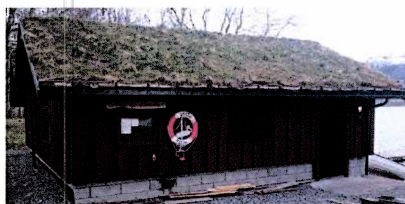
Ståande kledning, ca 75 kvm totalt
