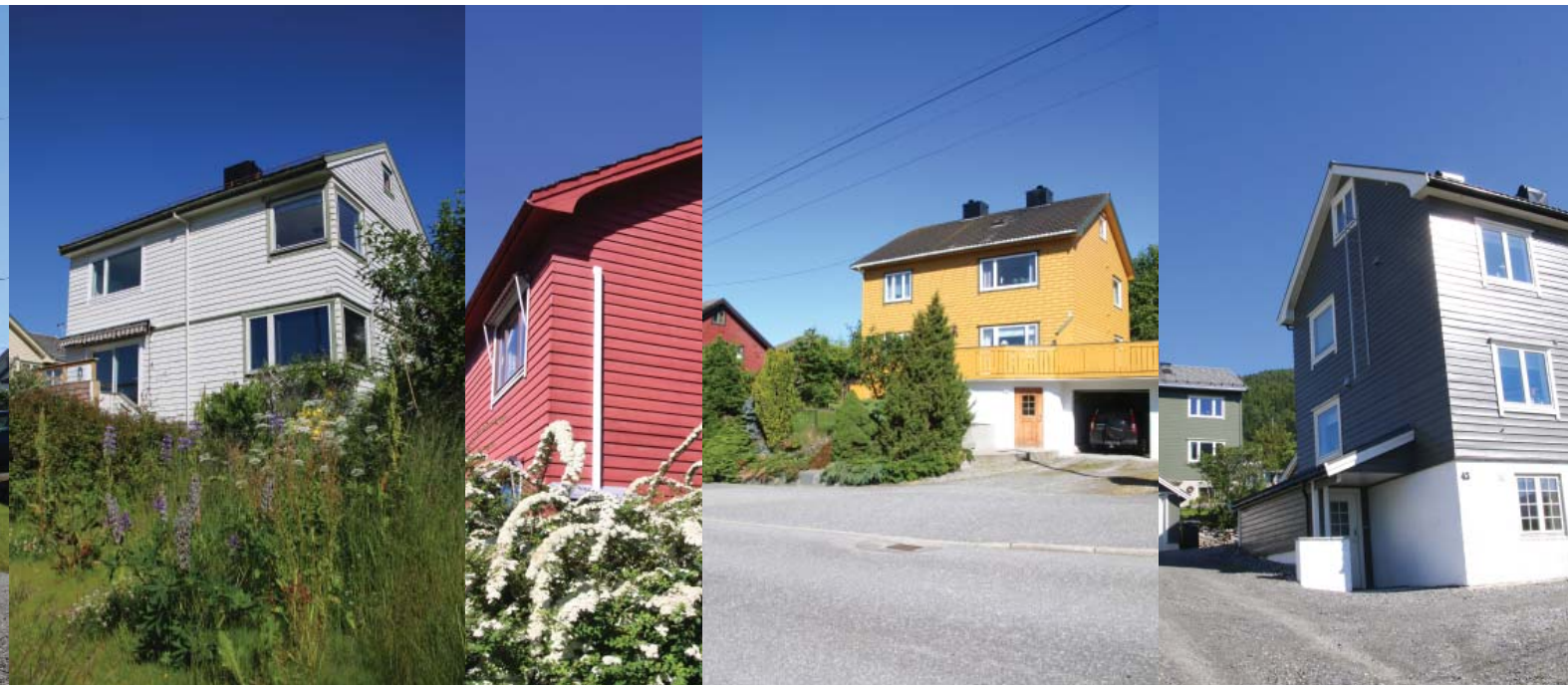
Vindauge i hushjørna.
