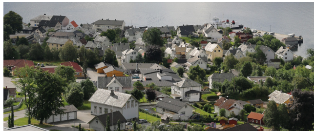
Utsikt frå Kleppåsen mot Hauane. Takflatene i sentrum er godt synlege frå mange stader i Volda.
