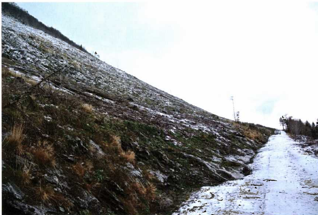
Figur 3: Bilde tatt mot nord-vest. Bilde viser flatehogd område og skogsbilveg. Det er etablert grøft på innsiden.
