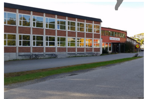
Ungdomsskolen i Volda i dårlig stand! SIGURD
