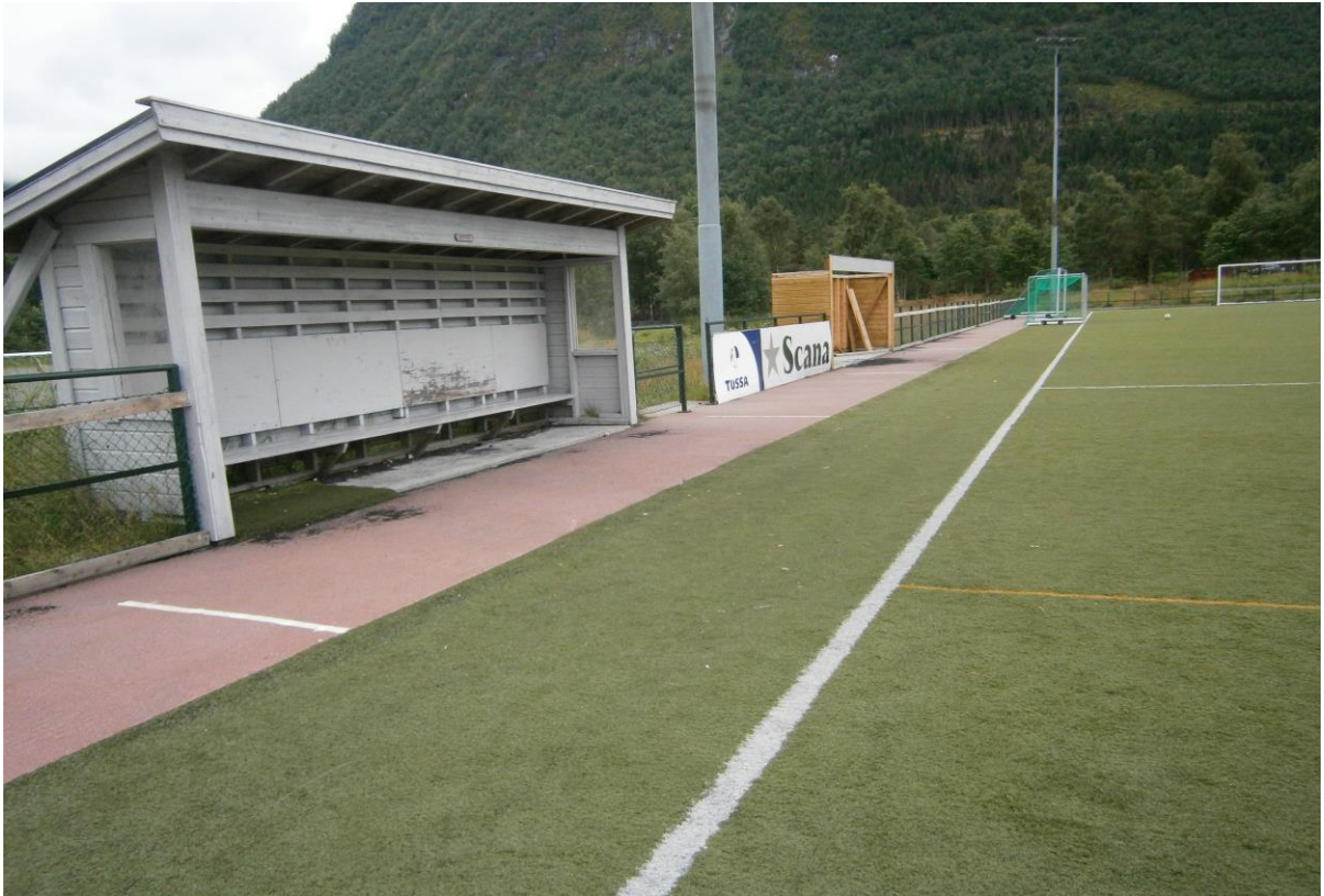
Sikkerhetssonene på langsiden ble målt til 3,9 meter
