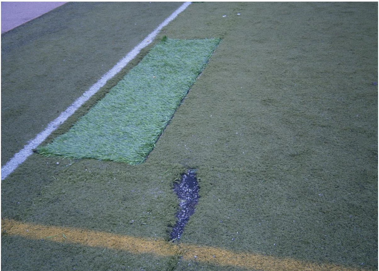
Innlimte stykker og til dels store revner i banedekket
