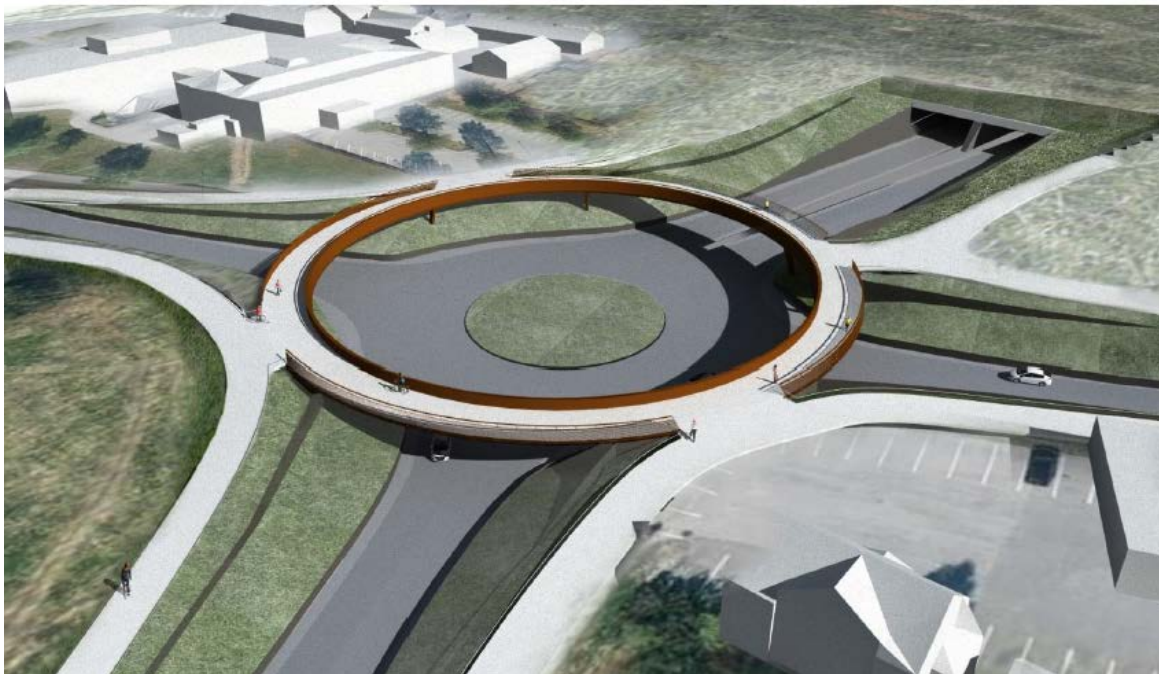
Figur 53 – Brukonsept «hjulbru» som løysing for gåande og syklande i Sjukehuskrysset. Illustrasjon: Rambøll AS
